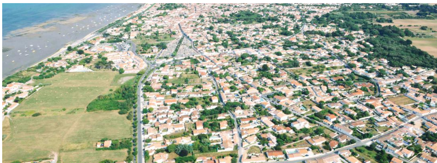
Vue aérienne du quartier de La Maladrerie à La Flotte-en-Ré
